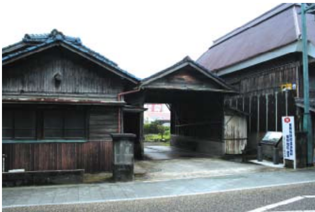
▲整備が待たれる検量所跡
