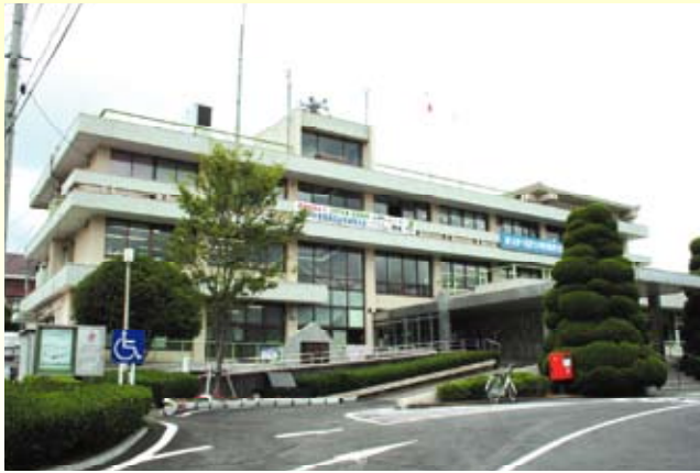
▲支 所（嬉野市庁舎）
