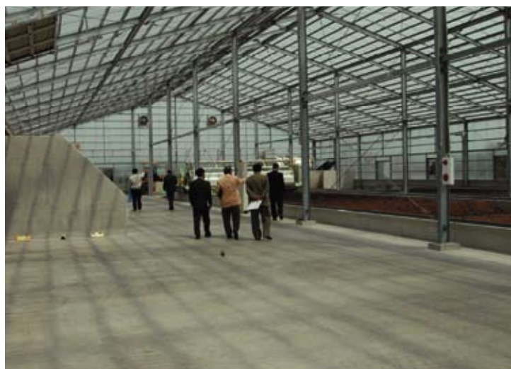
▲環境にやさしい循環型施設
