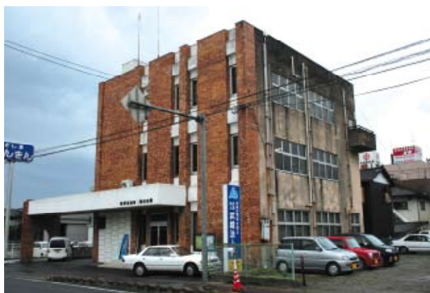
▲老朽化が進む嬉野商工会館
