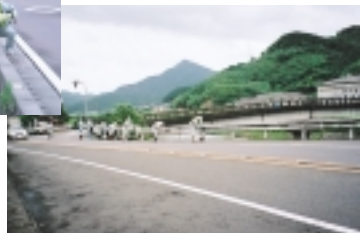
ガードレールや道路の清掃を行いました
