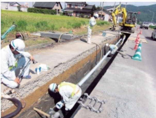
農集排の管伏設が進む塩田地区
