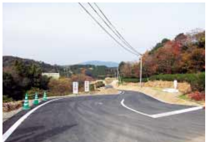
整備されているトンネルの工事用道路
