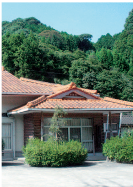
▲改修される上岩屋公民館
