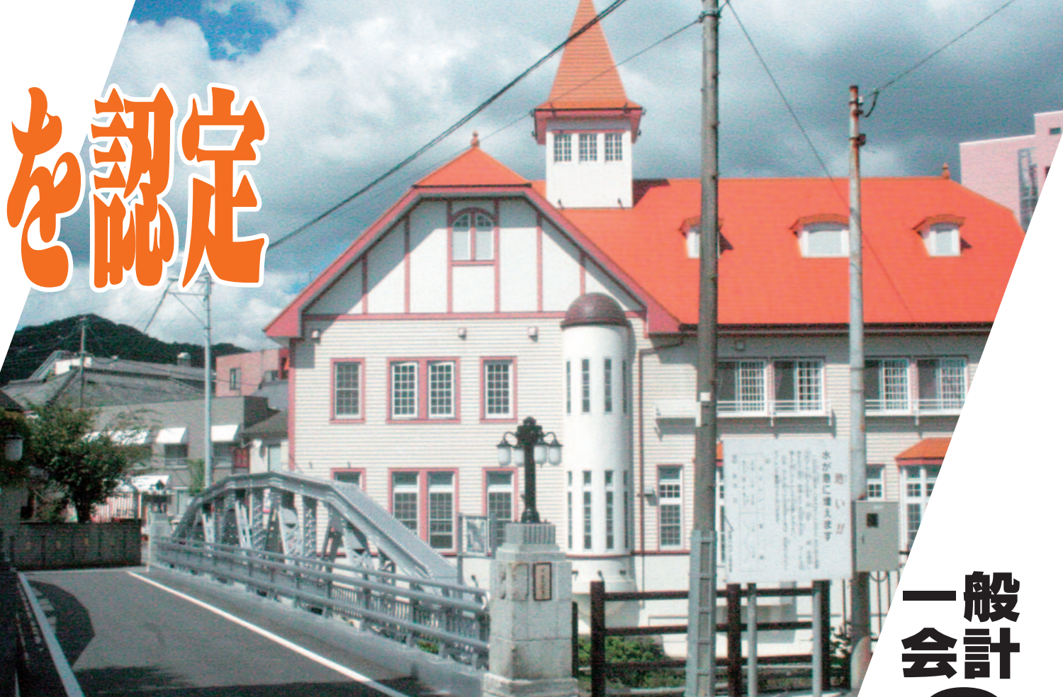
▲改修された嬉野橋
