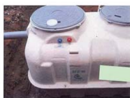
材料検収 小型合併処理浄化槽 フジクリーン CFII-10
