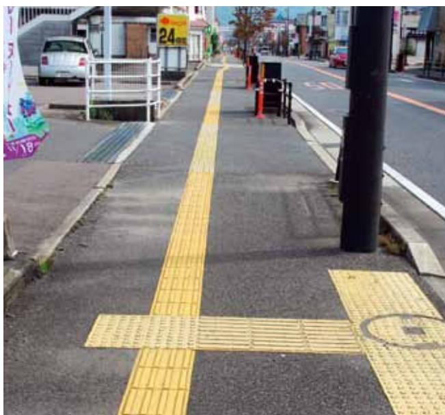
▲整備が進む点字ブロック
