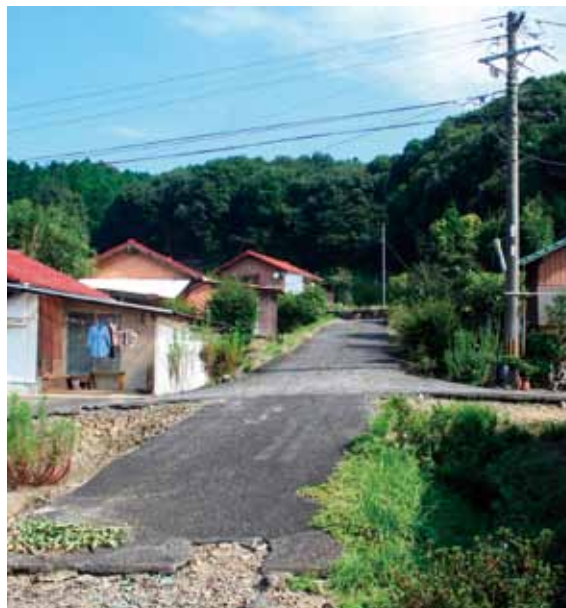
▲老朽化が進む市営住宅
