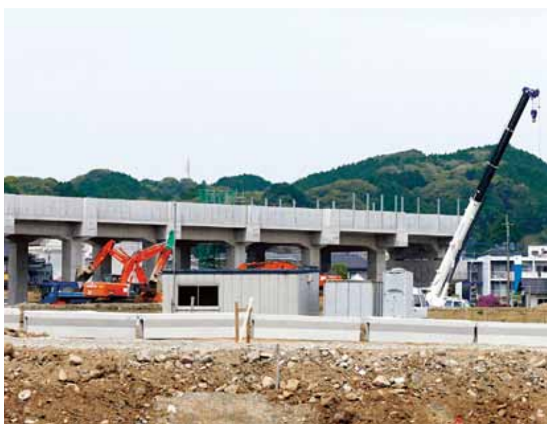
▲着々と工事が進む駅前広場
