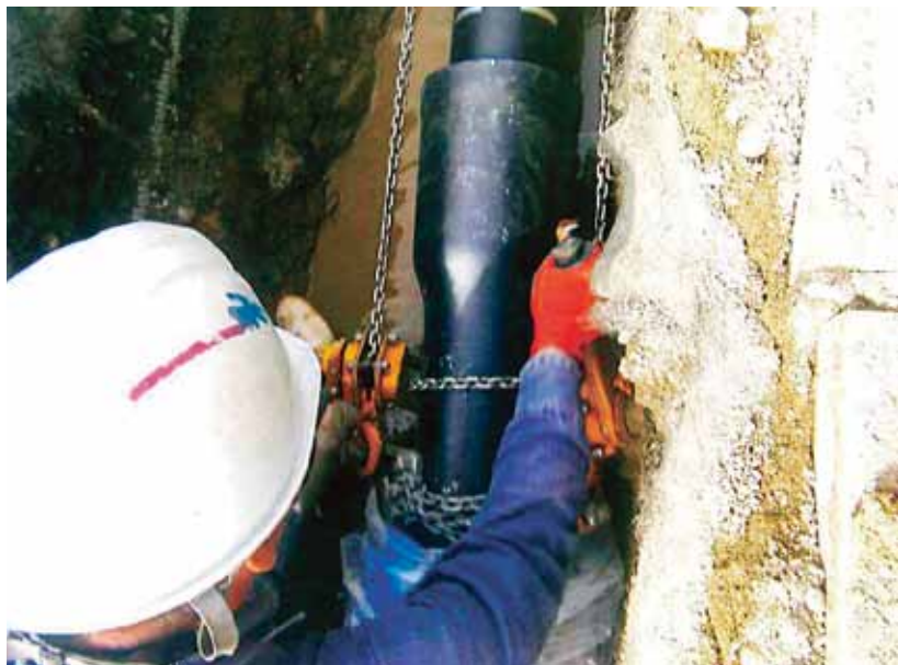
▲水道管老朽化の更新工事
