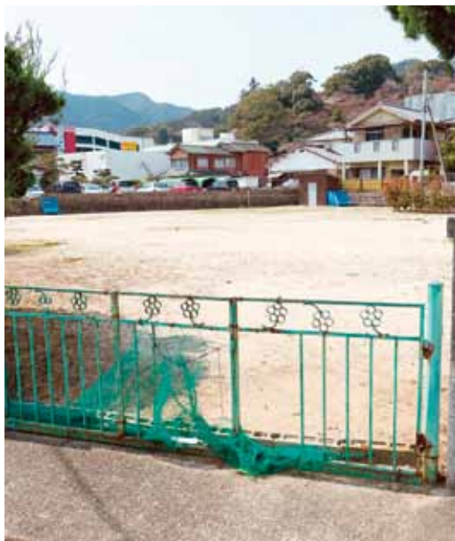
▲都市公園となる嬉野保育所跡地
