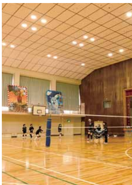
▲改修される体育館天井
