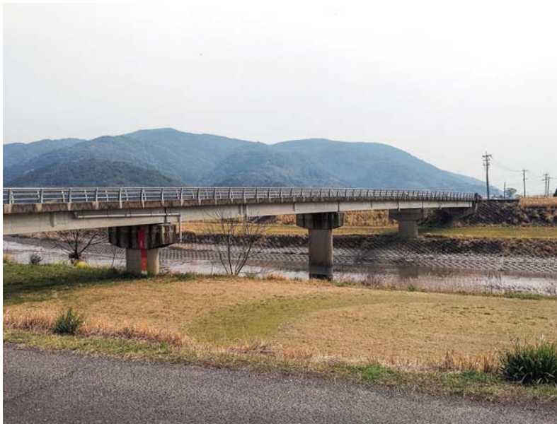
▲街路灯が欲しい袋大橋
