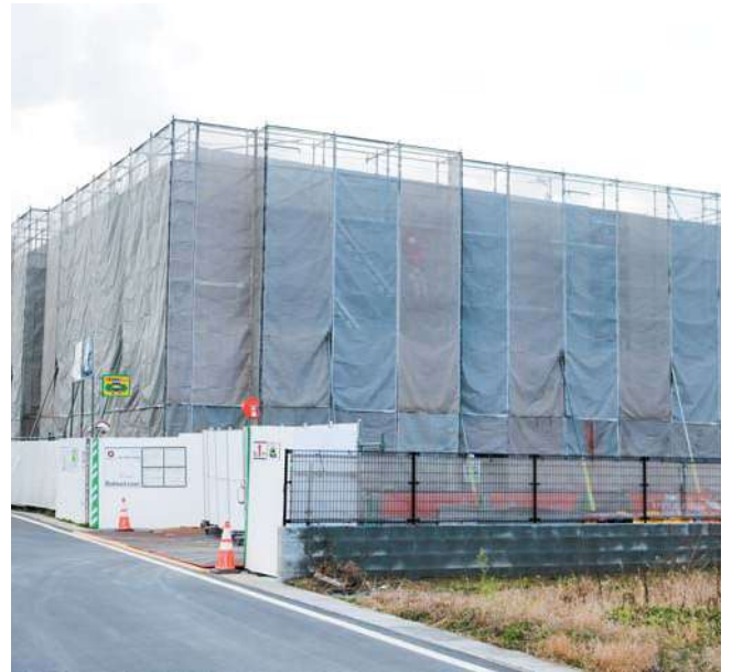
雇用に繋がれ（建設中の企業誘致ビル）
