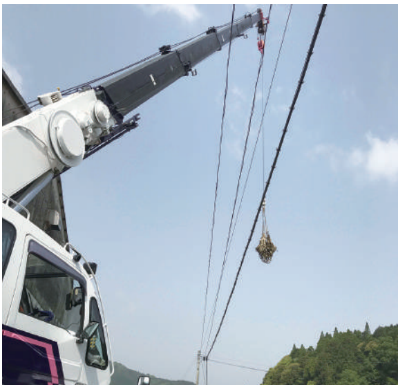
▲区役で多量の土砂を撤去するクレーン作業
