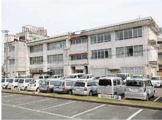
▲ 新庁舎建設予定地
